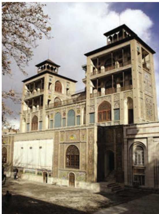
▲ شکل ۹-۱۳- شمس‌العماره، عمارت قاجاری، تهران
