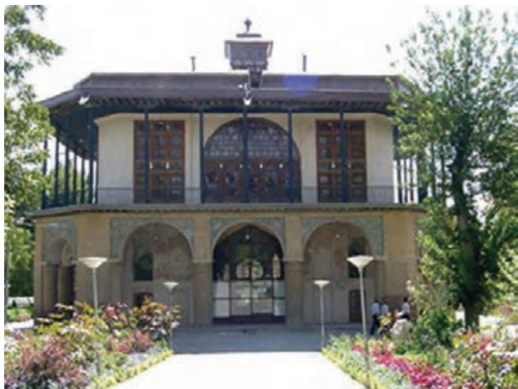
▲ شکل ۸-۱۲- عمارت چهلستون، قزوین
