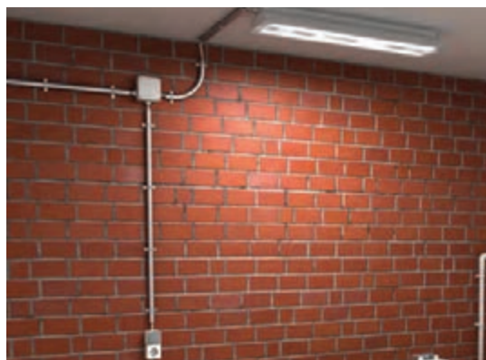
شکل ۳-۳۲- نمونه‌هایی از سیم‌کشی روکار
