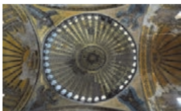
شکل ۹۴-۱- سقف گنبدی و نورگیرهای سقفی ایاصوفیه
